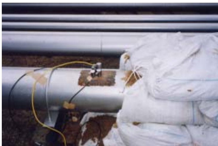
写真 2. 模擬埋設配管上に取り付けた AE センサー
